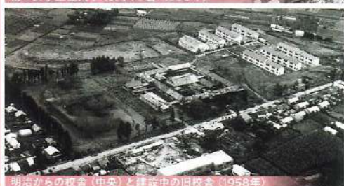
明治からの校舎（中央）と建替中の旧校舎（1958年）
