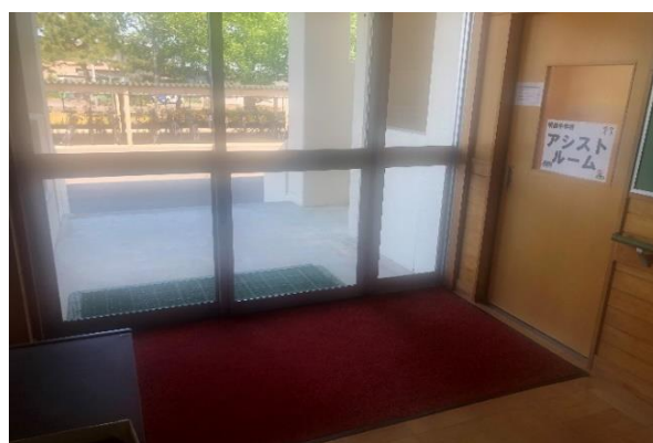
非常口のすぐ近くに設置
