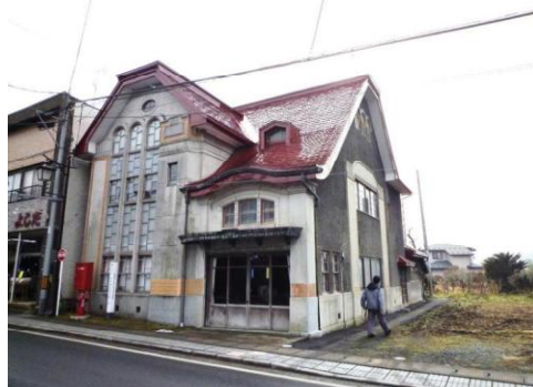
建造物のパトロールの様子 登録有形文化財 村井家住宅（南部町）
