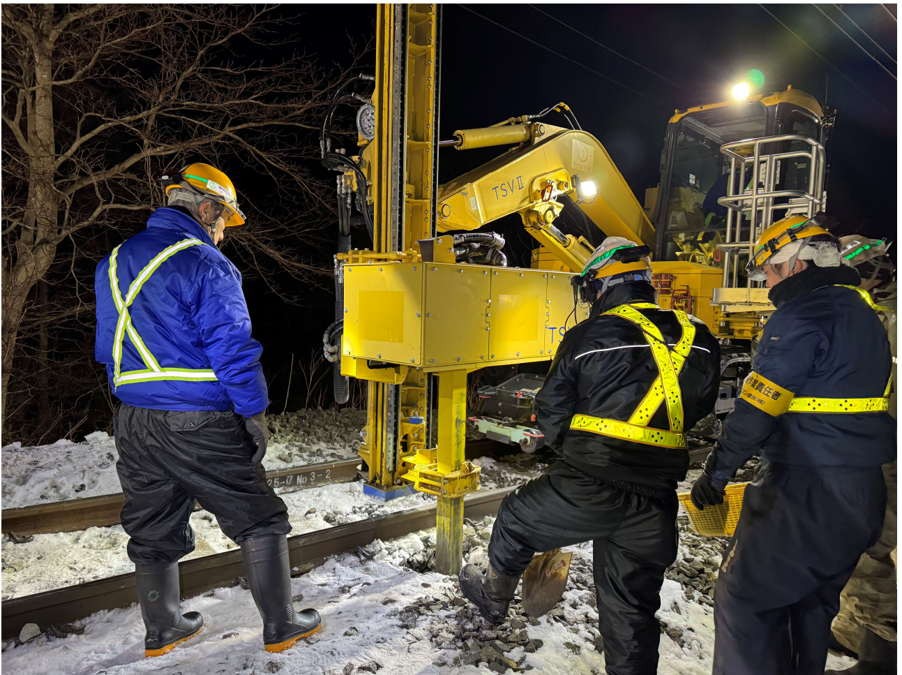
青森県東方沖地震による軌道変位の復旧工事（八戸～陸奥市川間）
