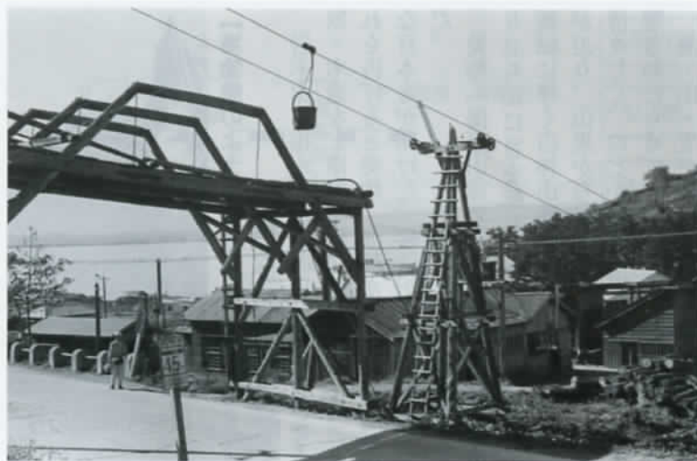
東岳の石灰岩を野内駅まで運ぶ架空索道
