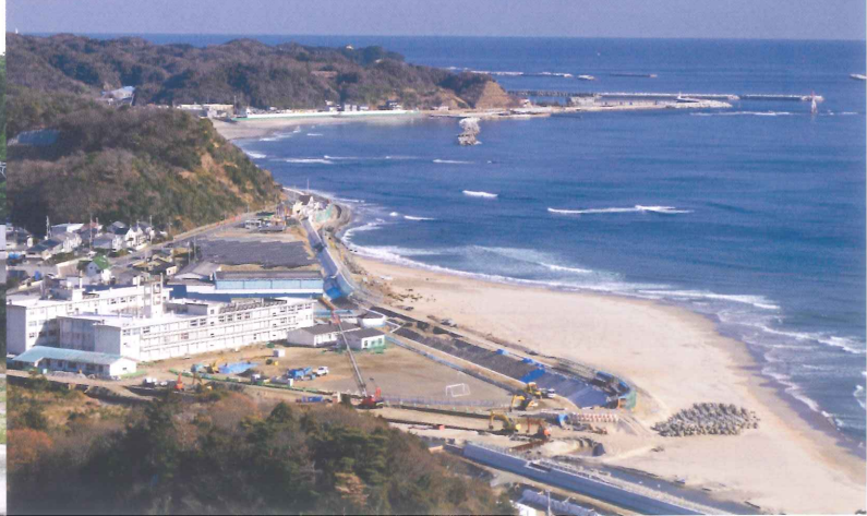
福島県 いわき市の防潮堤建設工事
