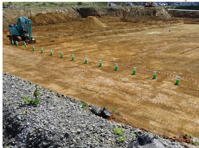
仮設5号地敷地造成(2019.9.12)
