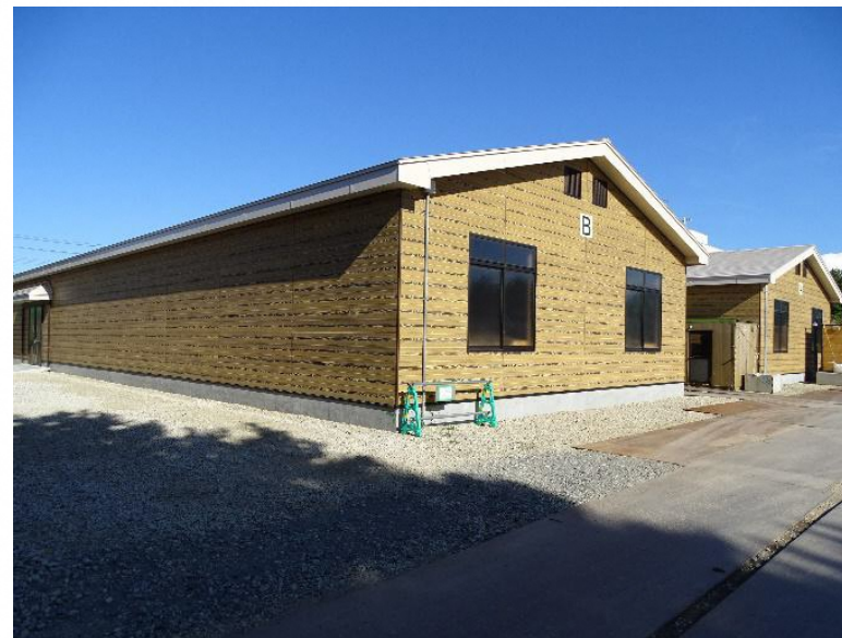
ボーリングコア倉庫AB棟(2019.9.4) 竣工済
