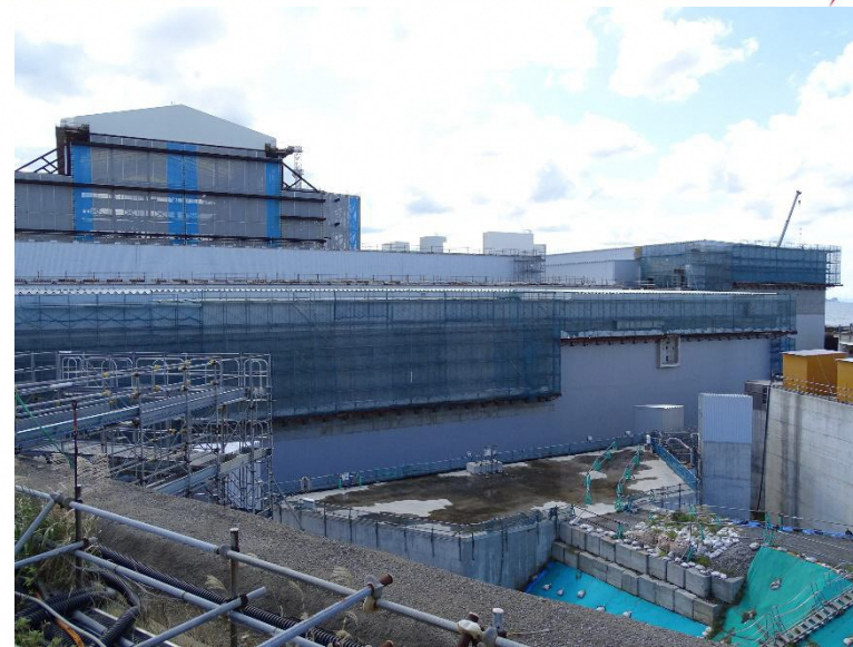
タービン建屋・廃棄物処理建屋(2019.9.12)
