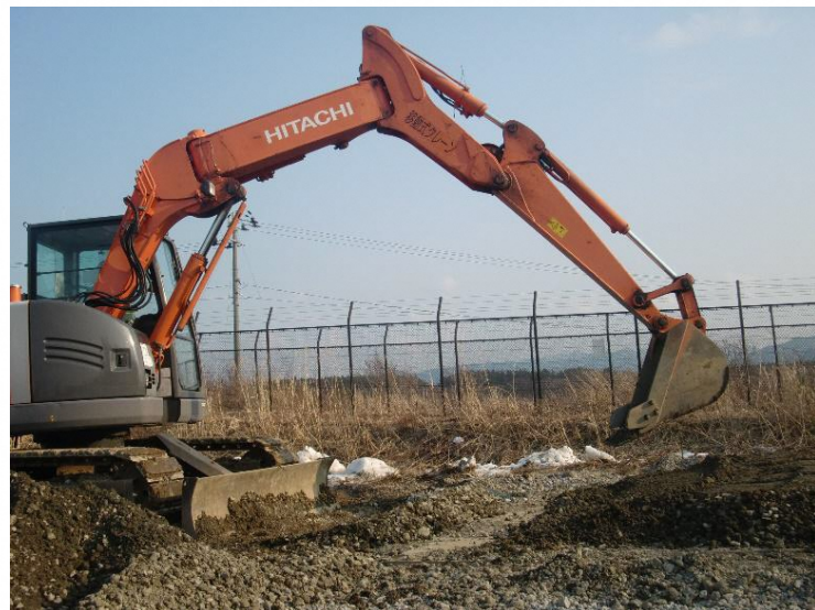
アクセス路啓開(バックホー)
