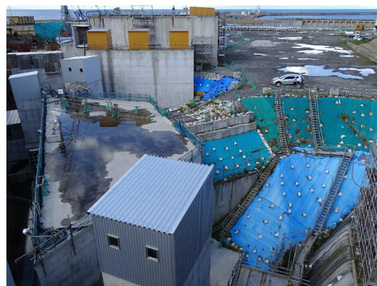
取・放水設備(2019.9.12)
