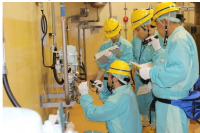
現場確認の実施状況
