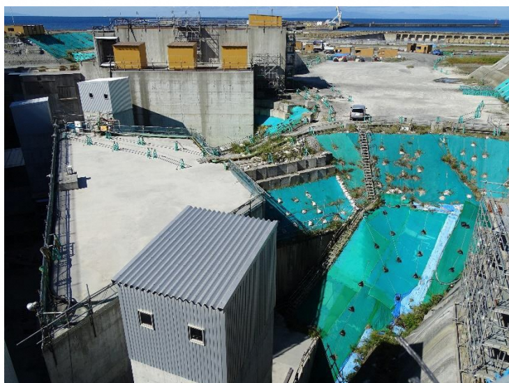
取水・放水設備(2022.9.15)
