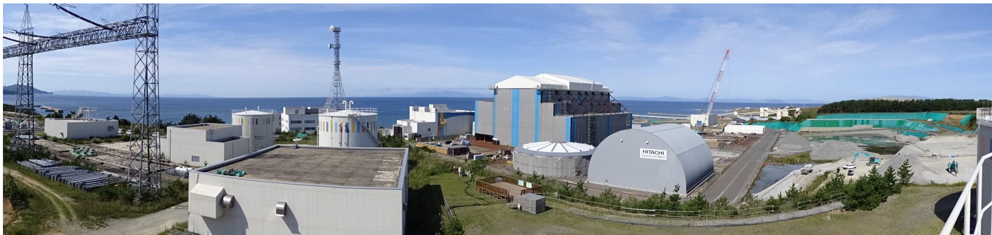
工事状況写真(2022年9月撮影)
