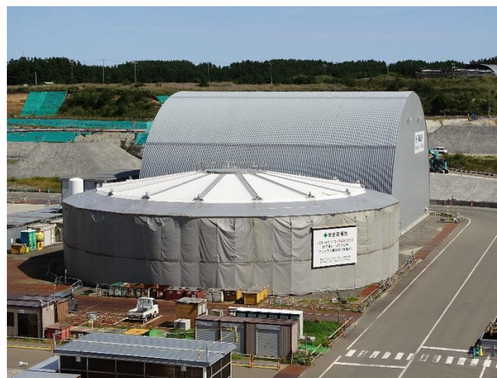
原子炉格納容器内モジュール(2022.9.15)
