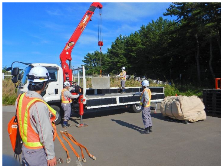
資機材荷役訓練
