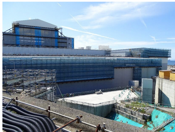
タービン建屋・廃棄物処理建屋(2022.9.15)
