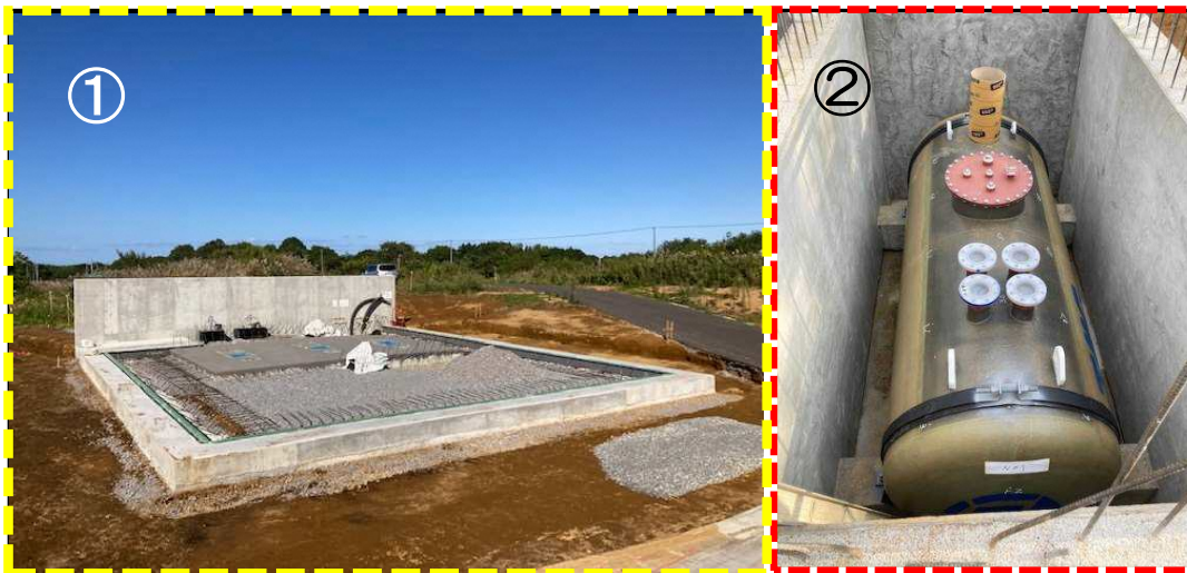
【軽油貯蔵タンク設置工事：2022年9月15日現在】
