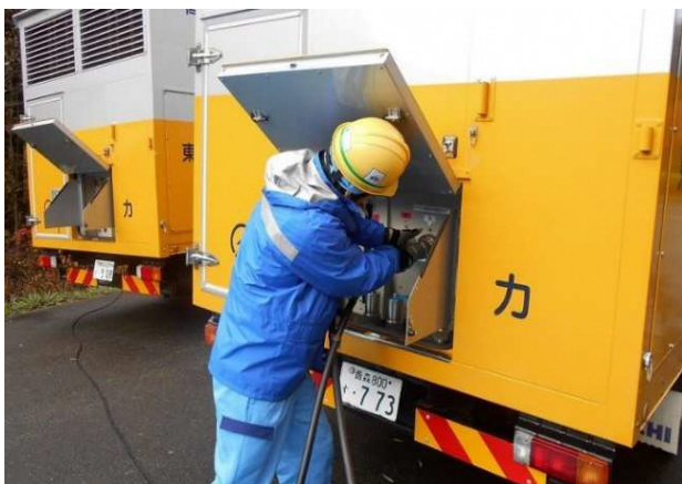
電源確保訓練（電源車の接続）
