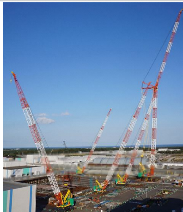
建設状況全体図(2022年10月現在)
