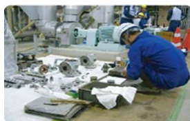
ポンプ分解点検
