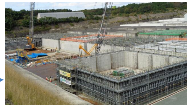
1号7,8群の工事の様子 (2022年10月現在)
