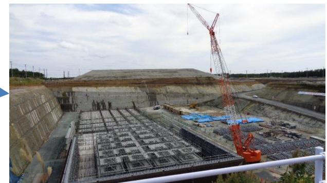
3号の工事の様子 (2022年10月現在)
