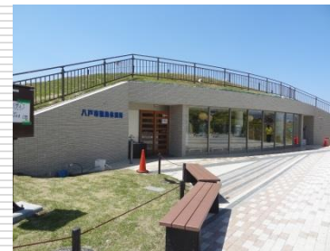
八戸市蕪島休憩所(八戸市)
