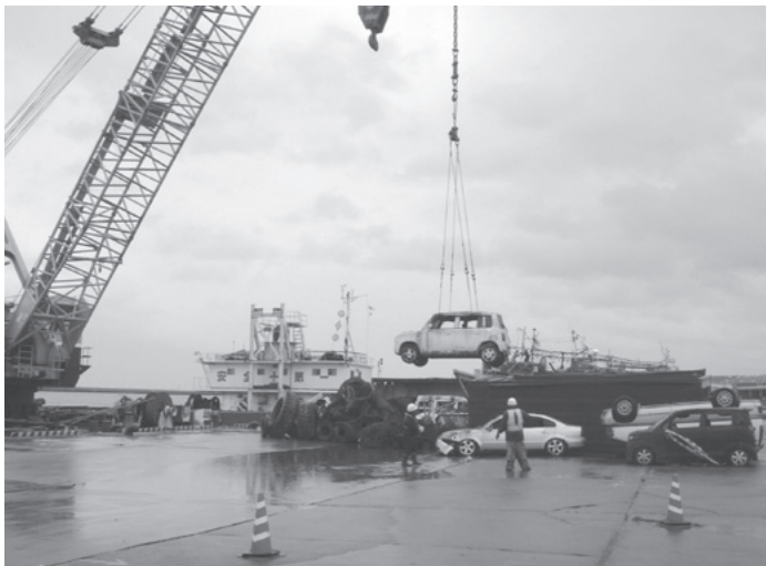
車両の撤去状況（八戸漁港）
