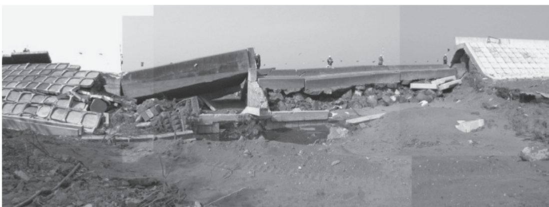
五戸川河川堤防被災後
