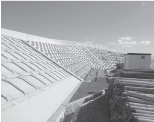
五戸川河川堤防復旧後
