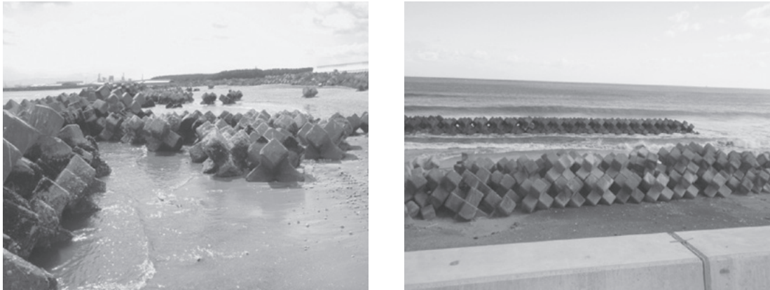
市川海岸（八戸市）被災後・復旧後
