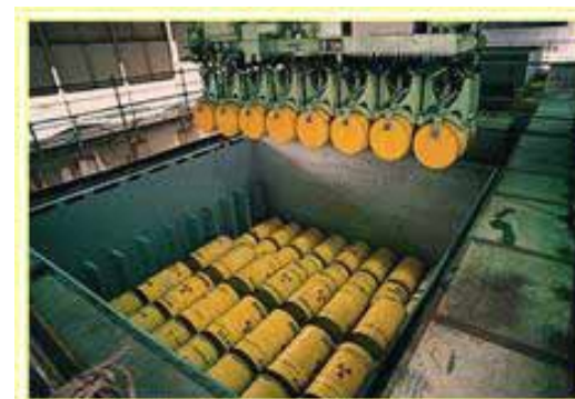
埋設ピットへのドラム缶定置作業風景
