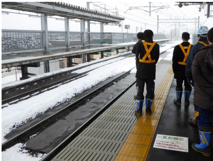
輸送障害の防止に向けて （平成28年度に新設された融雪マットヒーター（筒井駅））
