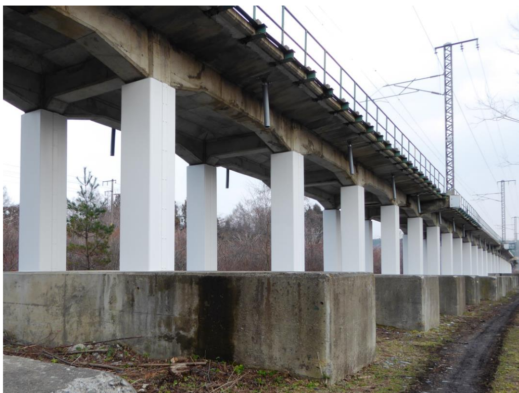
橋脚の耐震補強（三沢・小川原間 姉沼高架橋）
