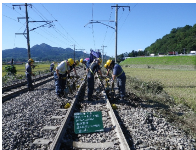
台風被害応急復旧作業（諏訪ノ平・剣吉間）
