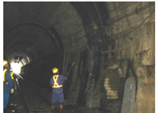
鉄道施設保守作業（つらら落とし）
