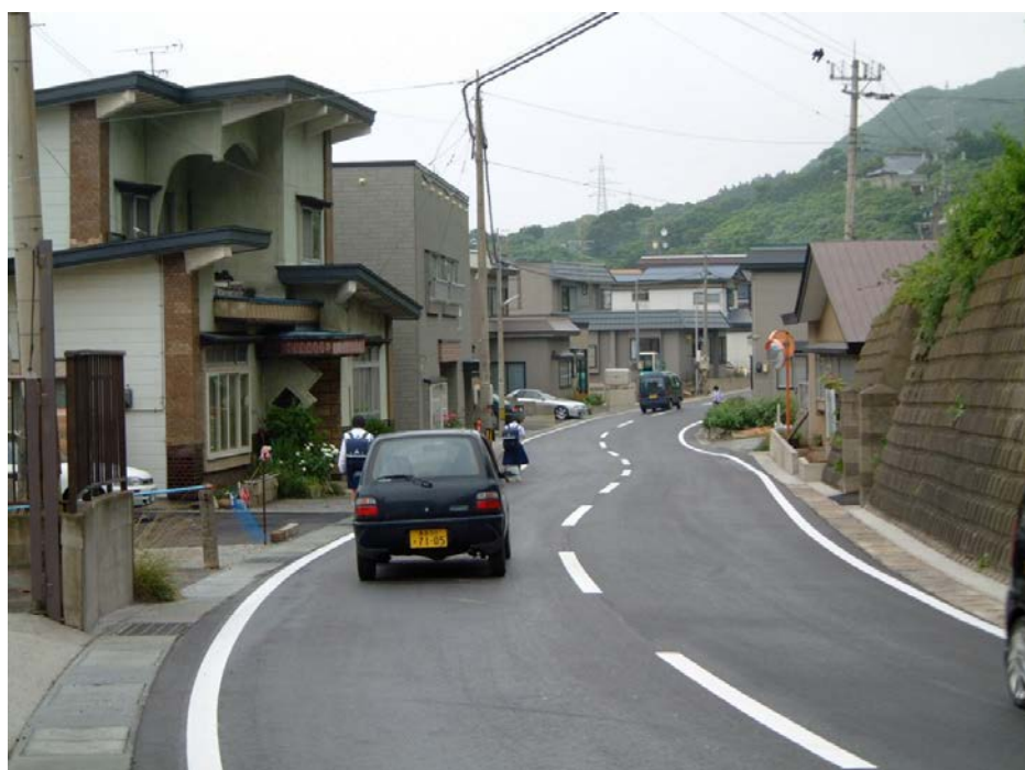
カーブが連続した住宅地を通過する区間
