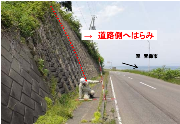
Dブロック末端 (井桁ブロック変状)
