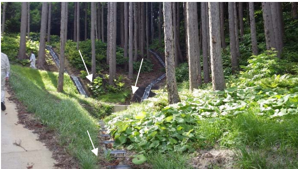
Dブロック 水路工
