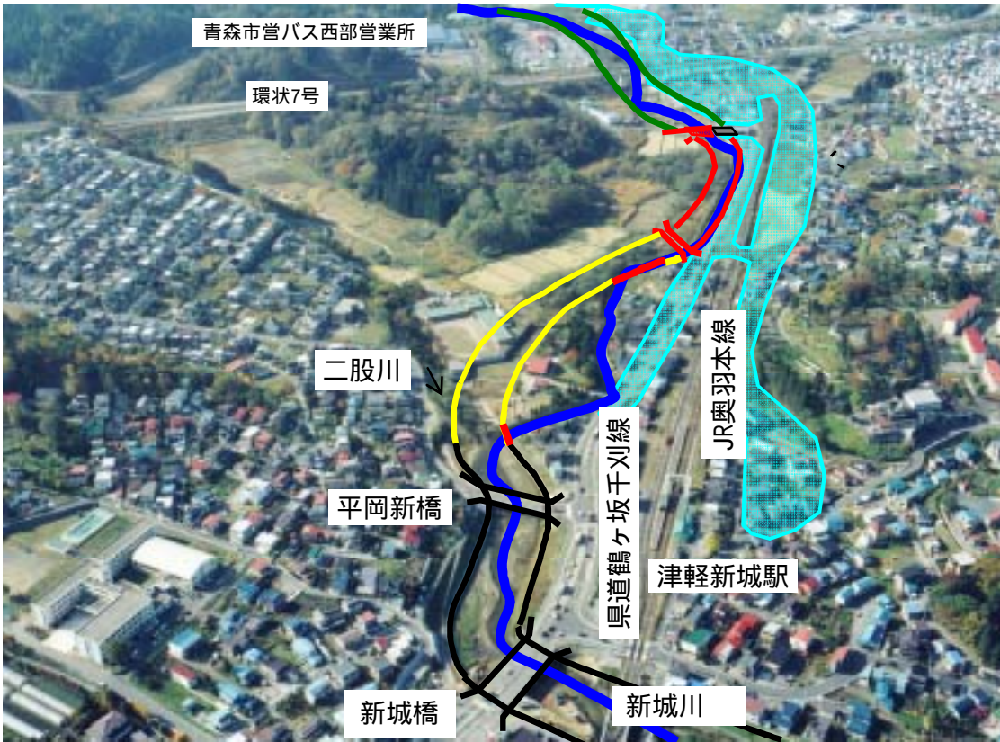
現況写真(未改修区間)
