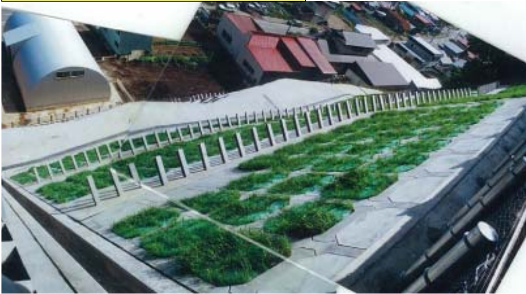
プレキャスト法枠工施工状況(斜面天端から望む)
