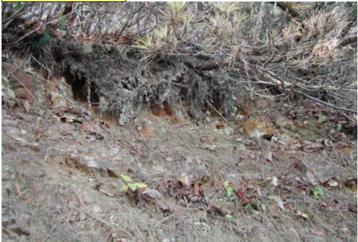
斜面崩壊状況(表層崩壊)
