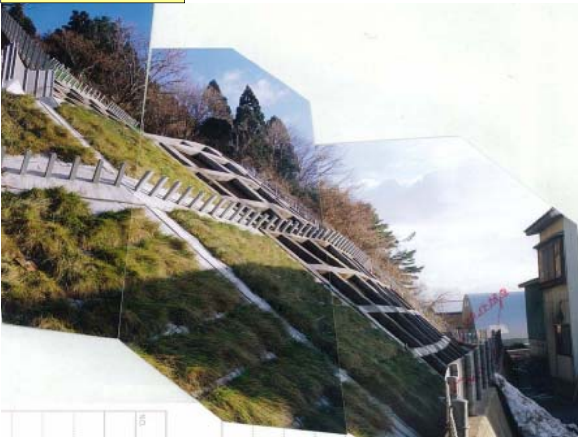
現場打吹付法枠工施工状況
