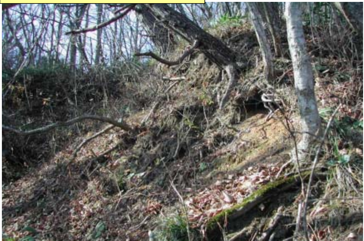
斜面崩壊状況(立木が不安定な状況にある)
