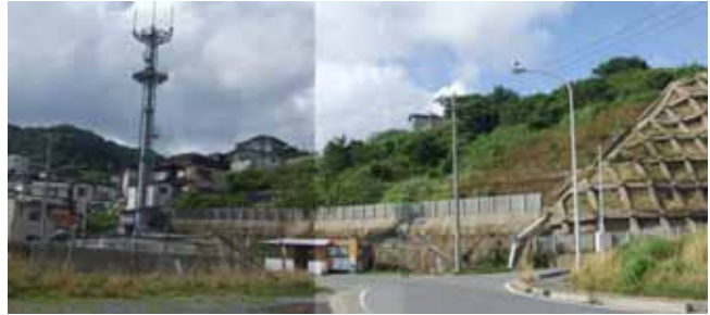
復旧後、現在の状況
