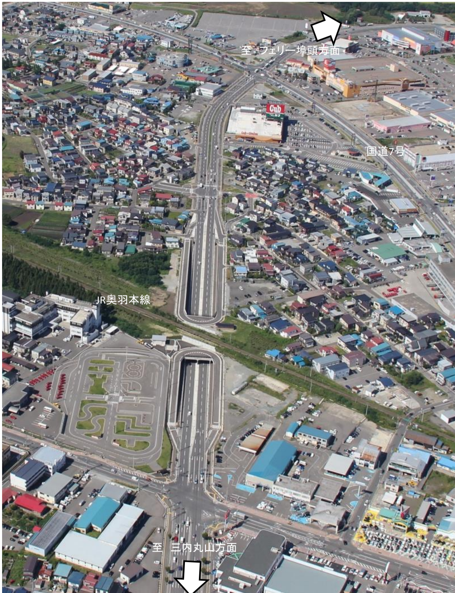
完成全景写真
