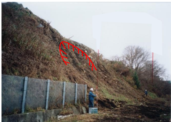
中間部(施工前)
