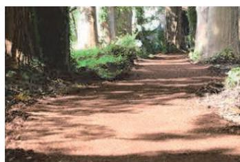
産業廃棄物として処理されている「杉の加工時に出る樹皮」を原料に、樹皮を繊維状になるまで粉砕して、練り混ぜて作成した舗装材。
