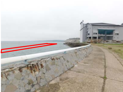
【東側工区 潜堤全景写真】
