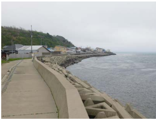
【西側工区 護岸全景写真】
