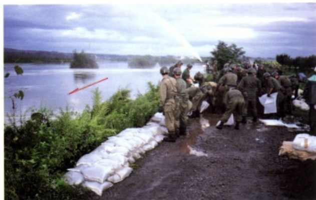
③ 浸水被害状況 (平成2年9月)
