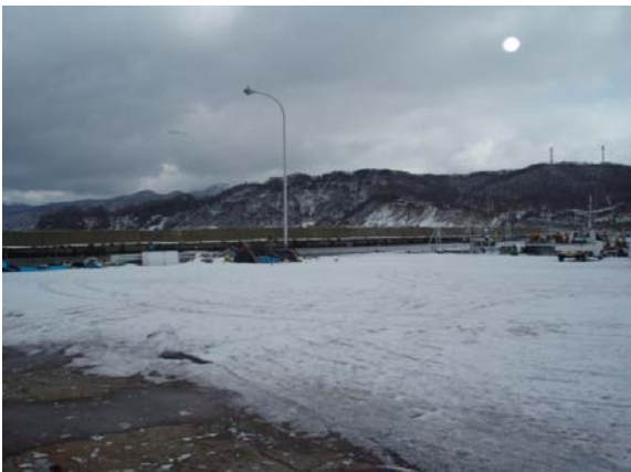
第3東防波堤の状況 (H23.1撮影)
