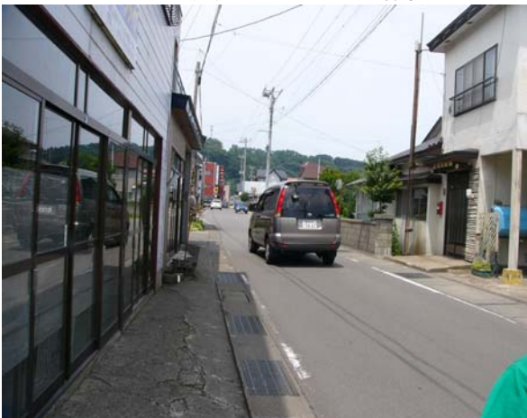
既設道路(町道)が狭く、特に漁獲物運搬等の大型車両の通行には大きな支障が生じる。(H22.5撮影)
