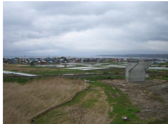
道路予定箇所の状況(H22.5撮影)
