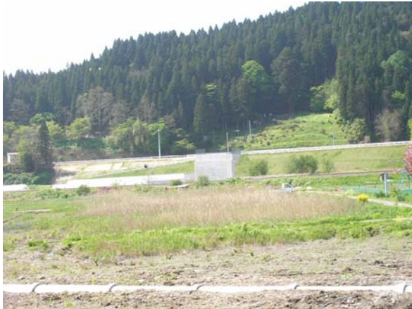
道路予定箇所の状況(H22.5撮影)
