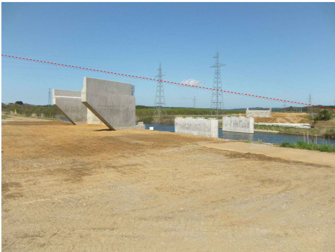
新田名部川橋(仮称):下部工完了後
