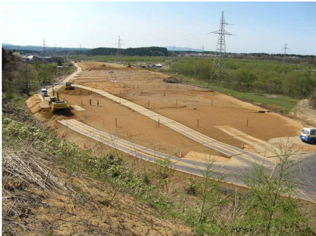
起点側軟弱地盤対策工事:サンドマット完了後
