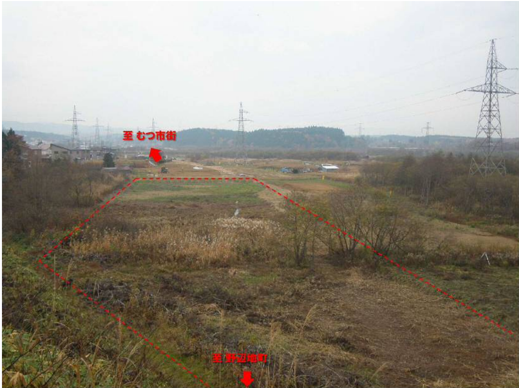
起点側軟弱地盤対策工事:着工前
