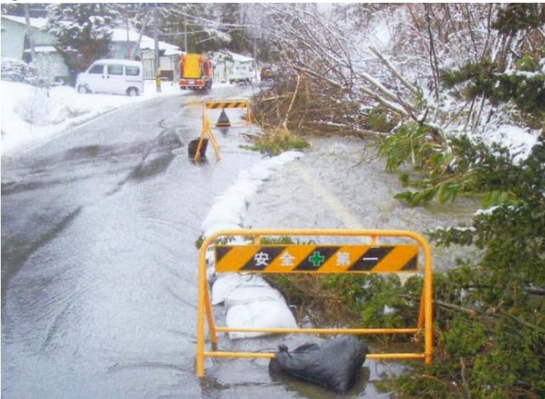
・斜面崩落により道路脇の用水路が埋設すると、道路が冠水することから、適正な水路断面の確保が必要である。
