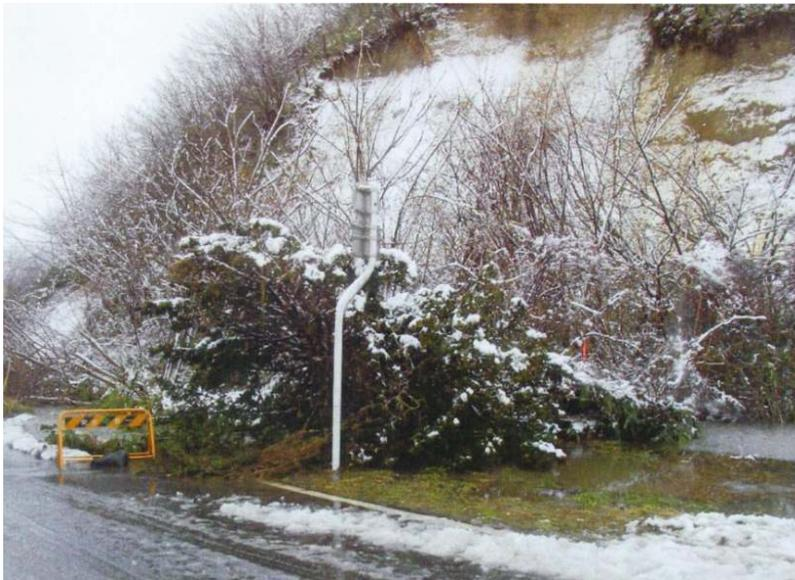
・降雨、降雪等により斜面の表層崩壊が発生したため、法面保護工を行う必要がある。
