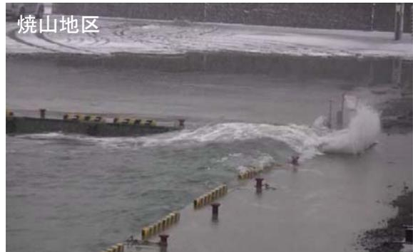
外郭施設の整備不足により、港内静穏度が非常に悪く、係船岸への浸水が発生しており、漁船の係留等に支障がある。
