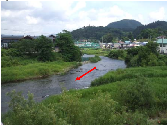
①現況写真(未改修区間)
