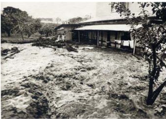
③浸水被害状況(昭和50年6月)
