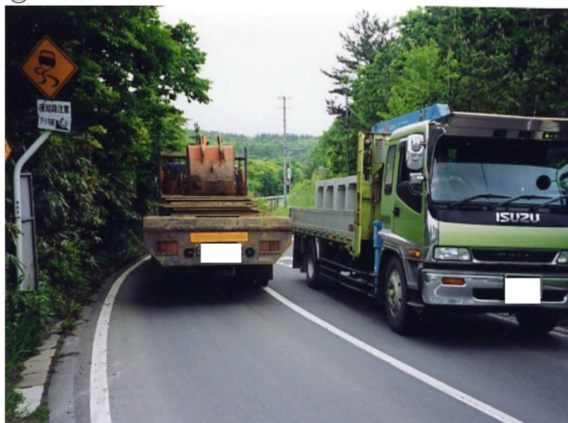
路肩が狭いことや急カーブ箇所に曲線部の拡幅がないため、大型車両同士のすれ違いは極めて危険な状態となっている。
