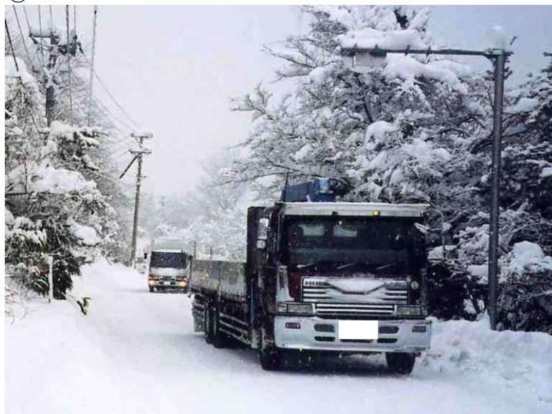
路肩が狭いため(堆雪幅がないため)、冬期間においては2車線の走行幅員が確保されず、車両同士のすれ違いが困難な状況となっている。
