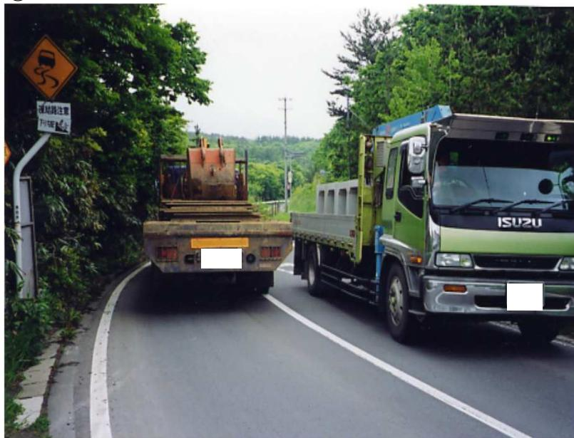
路肩が狭いことや急カーブ箇所に曲線部の拡幅がないため、大型車両同士のすれ違いは極めて危険な状態となっている。
