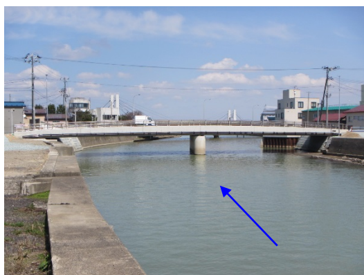
②現況写真(明海橋:改修後)
