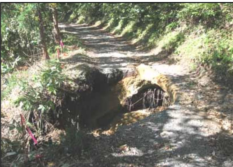
・排水施設が未整備であることから降雨により路面を走る雨水により、路盤材が流出し走行不能となる。
