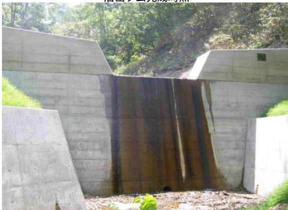
治山ダム完成時点
