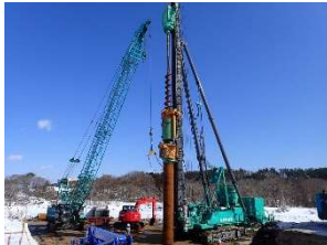
【施工状況（鋼管杭）】
