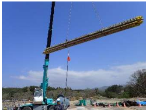
【施工状況（鋼管杭）】
