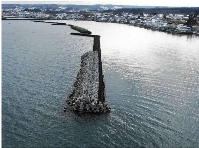
異形ブロック据付
