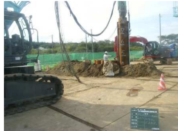
【補助工法(砂置換)】
