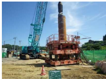
【補助工法(砂置換)】
