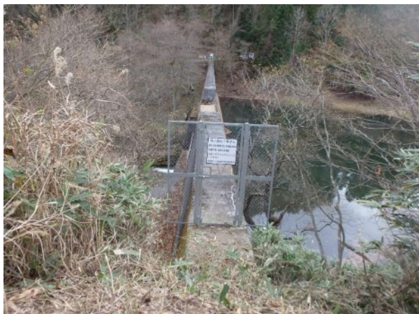
○測量位置 (市の渡川砂防ダム)
