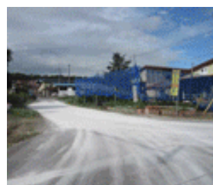
消石灰帯の設置
