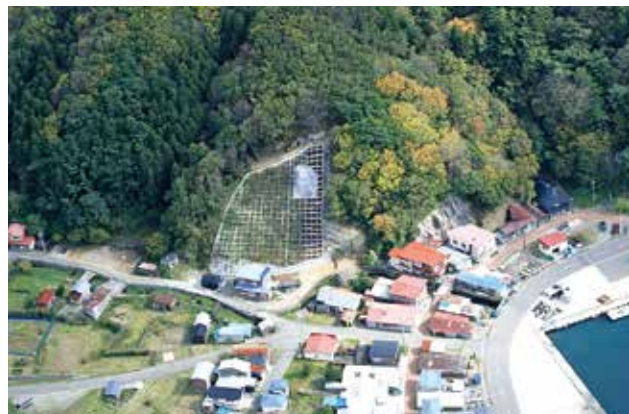
九艘泊区域急傾斜地崩壊対策事業(むつ市脇野沢九艘泊) 現場打吹付法砕工
