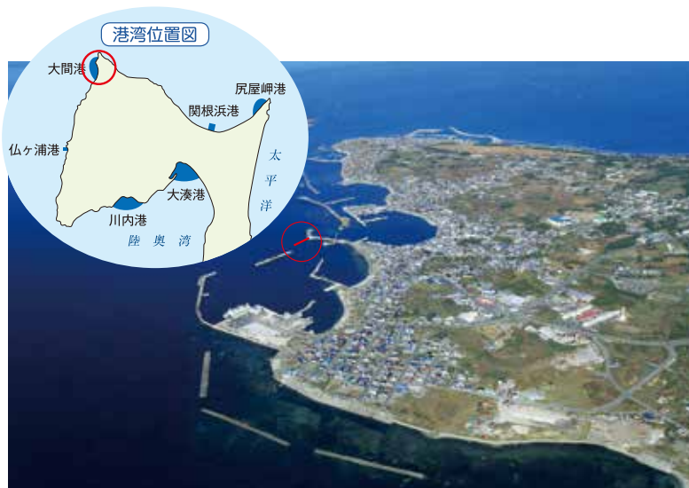
大間港湾地方創生推進事業箇所(防波堤工事)
