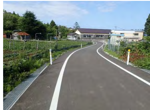
整備後の農道（風間浦村）
