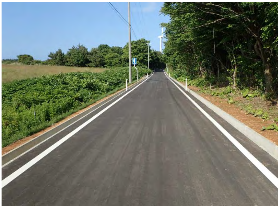
整備後の農道（中山間地域総合整備事業・大間町）
