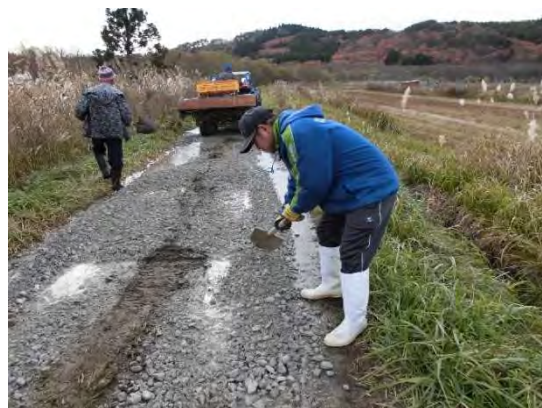
農道の補修作業（東通村）
