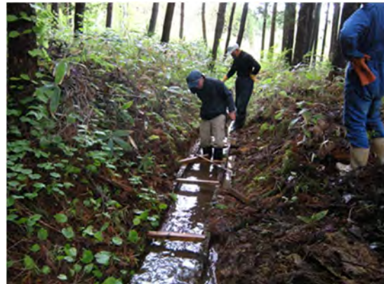
水路の補修（風間浦村）
