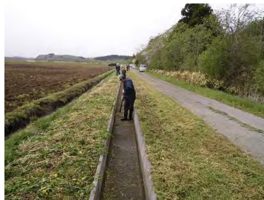
水路の泥上げ（東通村）
