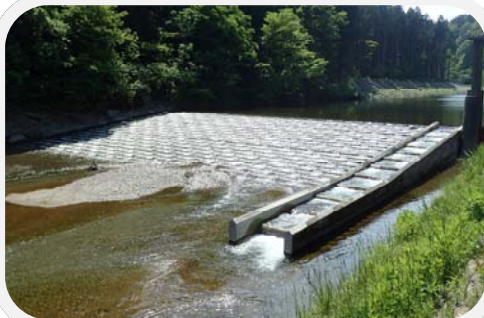
写真：堰と魚道
