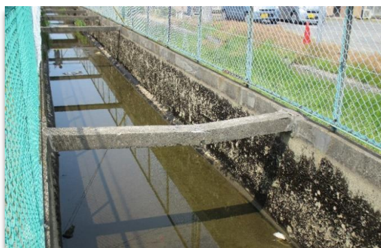
基幹水利施設ストックマネジメント事業 下長2期地区（八戸市、R3～R7） 農業用水路の改修（整備前）
