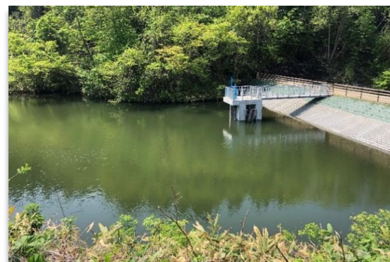
改修後のため池
