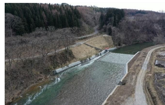
魚道整備後の舞手頭首工 （舞手地区：R2）
