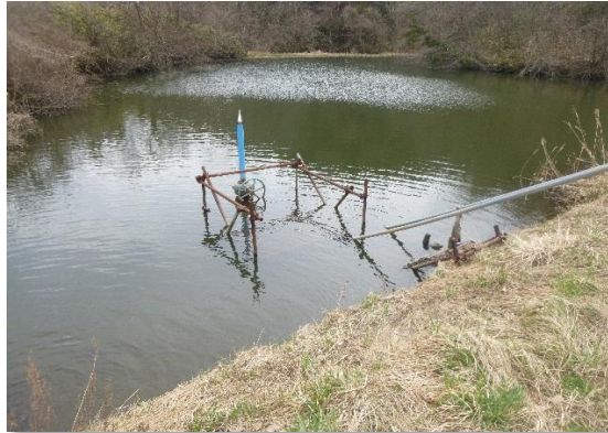
改修前のため池
