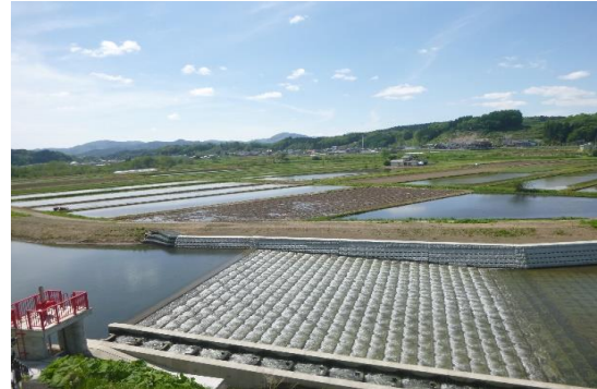
農業水利施設魚道整備促進事業 舞手地区（田子町、H29～R3） 魚道の整備
