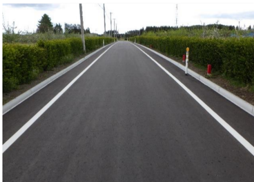
通作条件整備事業 地蔵平地区（五戸町、H29～R3） 一般農道の路面改良
