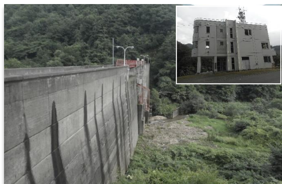
防災ダム事業 夏坂ダム地区（田子町、R3～R8） 防災用ダムの施設改修（整備前）
