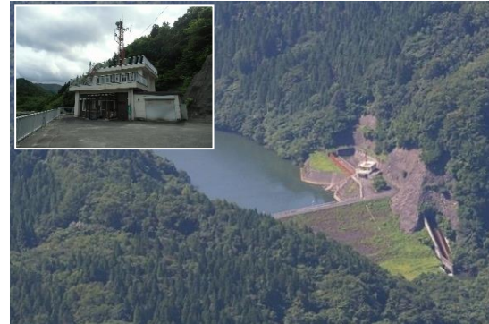
防災ダム事業 花木ダム地区（田子町、R4～R8） 防災用ダムの施設改修（整備前）
