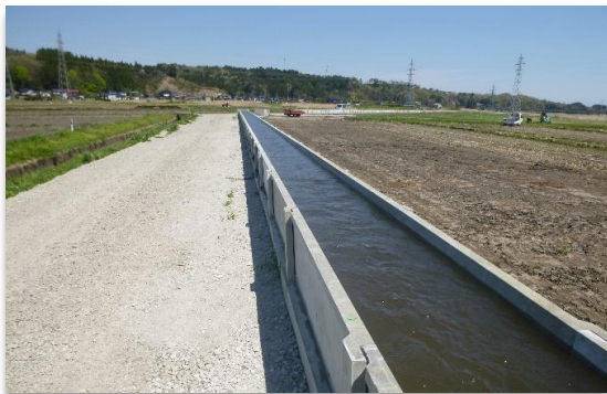
農業水路等長寿命化・防災減災事業 下長西部地区（八戸市、H30～R2） 農業用水路の改修
