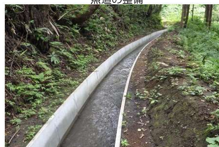
ため池等整備事業（用排水施設整備） 三川目地区（新郷村、H28～R3） 農業用水路の改修
