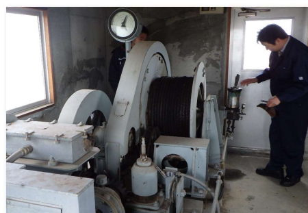
基幹水利施設ストックマネジメント事業 頭首工の調査
