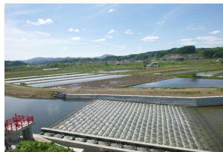
農業水利施設魚道整備促進事業 舞手地区（田子町、H29～R3） 魚道の整備
