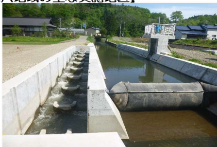
農業用河川工作物応急対策事業 西越田中地区（新郷村、H29～R2） 頭首工の改修
