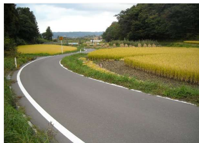
畑地帯総合整備事業 上名久井地区（南部町、H12～H21） 農道、農業用排水路等の整備
