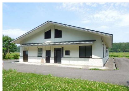
農業集落排水事業 石沢地区（五戸町、H5～H8） 農業集落排水処理施設の整備
