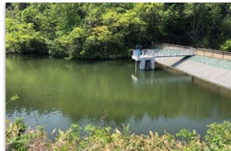
改修後のため池
