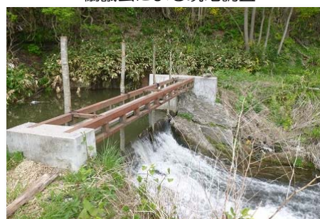
魚道整備前の上堰（西越田中地区）
